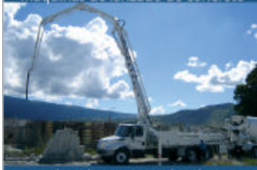
Bombas de concreto de pluma
